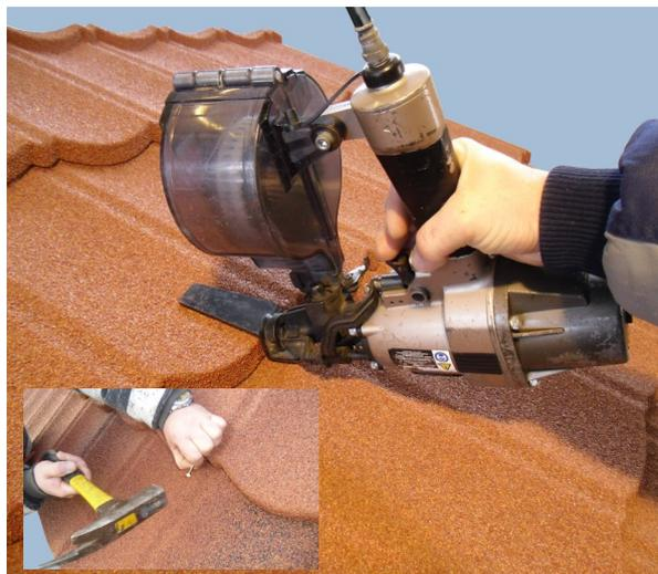
Die Dachplatten werden stirnseitig in jeder 2. Welle befestigt; 4x pro Platte. Verwenden Sie nur mitgelieferte Schrauben (selbstbohrend) bzw. Schraubnägeln. Eine Nagelmaschine kann bei großen Flächen recht hilfreich sein und nach Absprache bereit gestellt werden.
